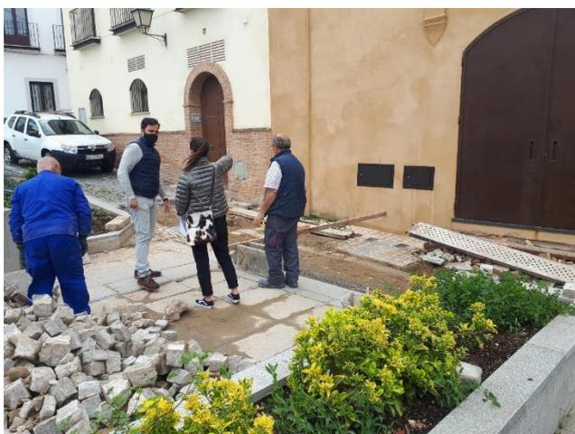
La actuación se ha centrado por un lado en la creación de un itinerario peatonal accesible de suave pendiente, y por la zona inferior de la calle a través de una rampa accesible complementada con un tramo de escalera. Además, se ha resuelto la conexión con la plaza Santa María mediante un plano de suave pendiente al no ser
